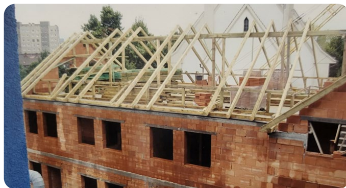
Budowa plebanii - dach
