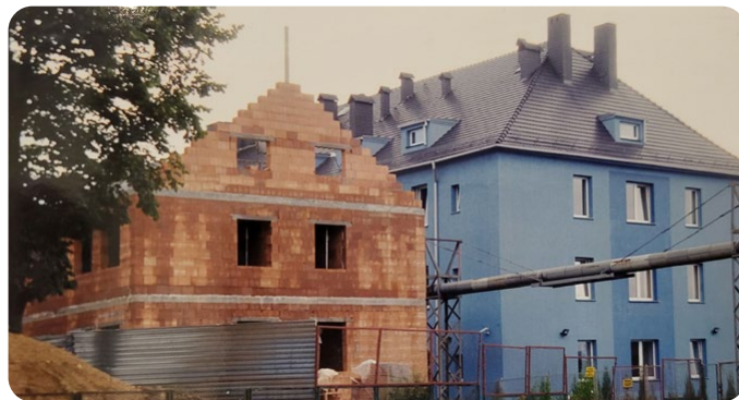
Budowa plebanii stan surowy
